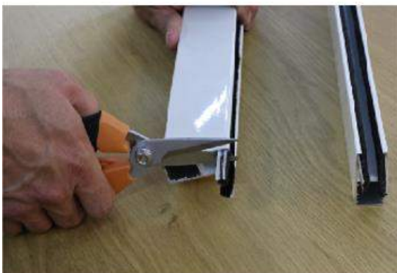
Zorg ervoor dat de uiteinden aan 1 zijde gelijk zitten met het uiteinde van het profiel. Knip het teveel van de borstelafdichting af.
