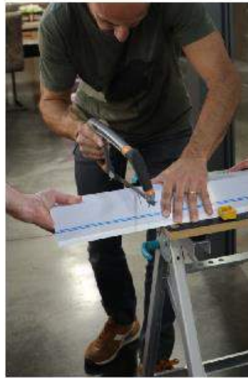
Kort de voorzijde van de rolluik- koffer in.
